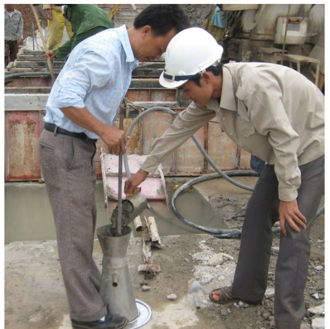
Kiểm tra độ sụt bê tông
