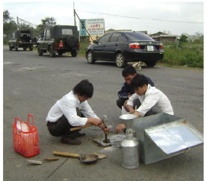
Kiểm tra độ chặt K - đường giao thông
