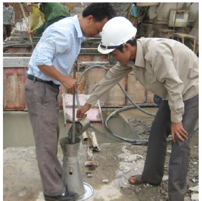
Kiểm tra độ sụt bê tông
